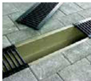
Po sejmutí krycího roštu lze žlab jednoduše vyčistit.
